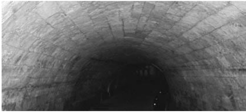
Túnel construido por los templarios en San Juan de Acre para unir sus fortalezas.
